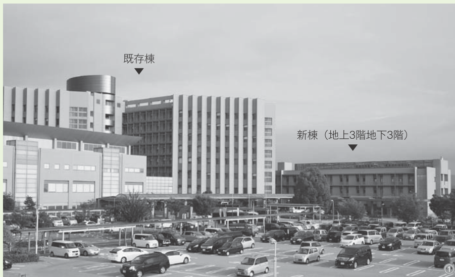
①岡崎市民病院外観 ②外来 ③病棟（4人床9室、2人床2室、個室10室）
